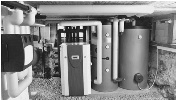
Wärmepumpen wandeln die Umweltwärme tieferer Temperatur in Heizwärme höherer Temperatur um. Das Bild zeigt eine Wärmepumpe, die Erdwärme mithilfe einer Erdsonde nutzt.
