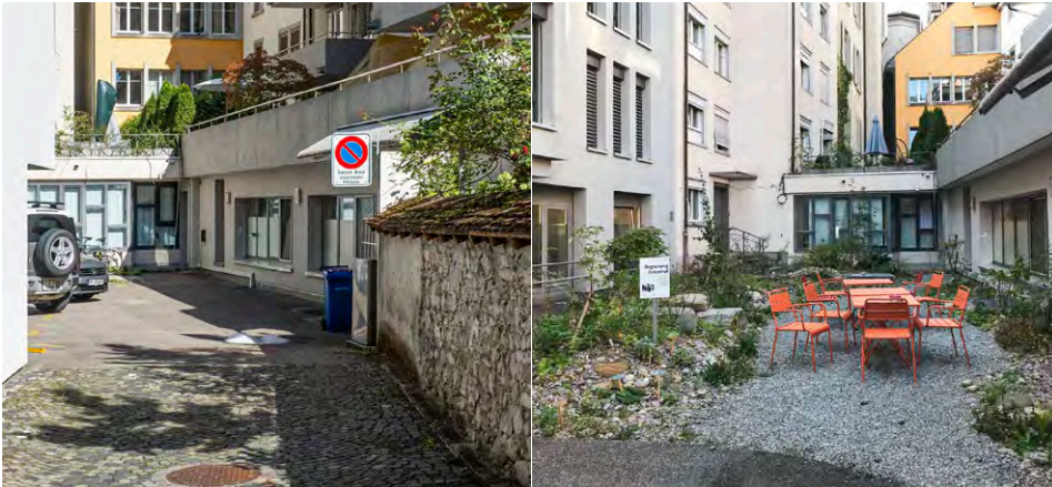
Nachdem der Asphalt geknackt wurde, blüht es nach nur einem Jahr auf und es lässt sich verweilen im Innenhof. Copyright: Reto Kluser Fotografie und GSI Architekten
